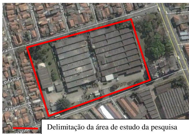
Figura 3 - Fotografia aérea da área escolhida para a pesquisa em 2004, com as instalações industriais.
