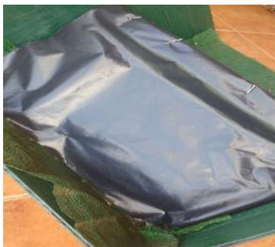
Figura 3 – Camada de impermeabilização
