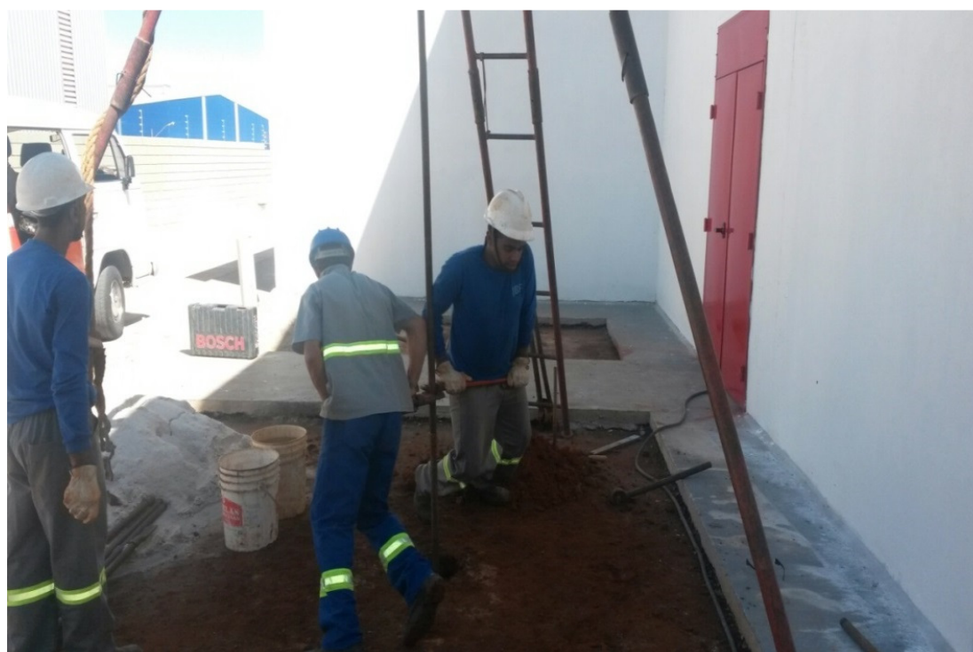
Figura 2. Perfuração do poço com trado manual
