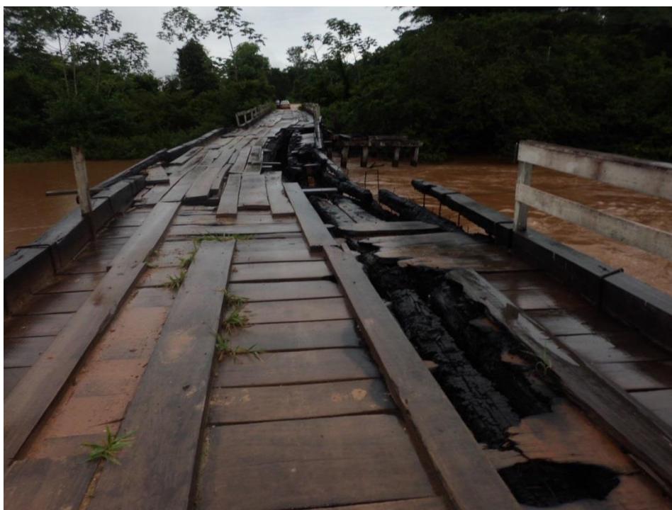
Ponte sobre o rio Pimenta, Rondônia. Foto: Larissa Ruas.
